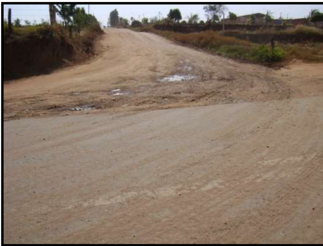
Figura 37 - Vista à montante do Anel Viário Pedro Antônio Escabosa Lopes
