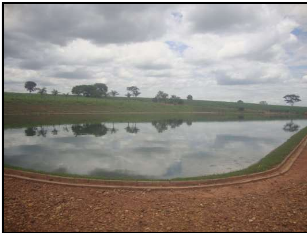
Figura 17 - Lagoa de tratamento 02
