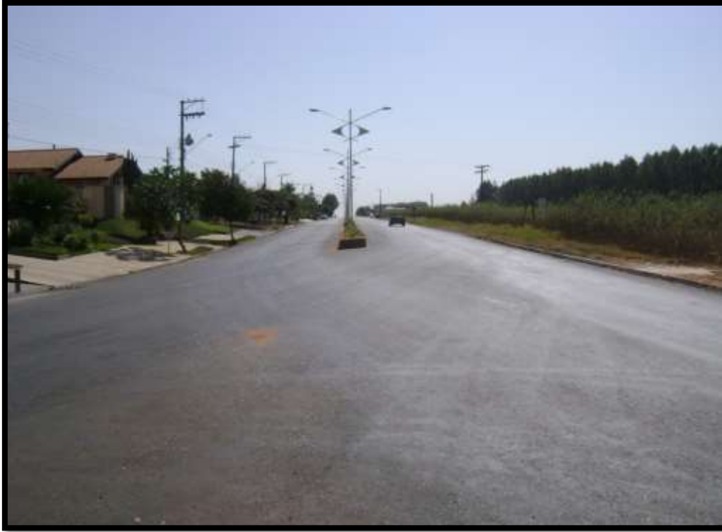
Figura 39 - Vista da Avenida Antonio Rotta, à montante
