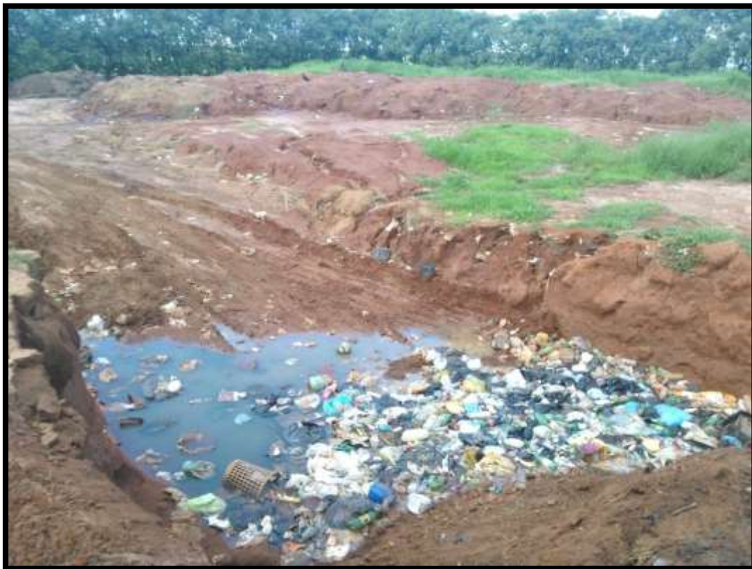
Figura 21 - Resíduos sem cobertura nas valas
