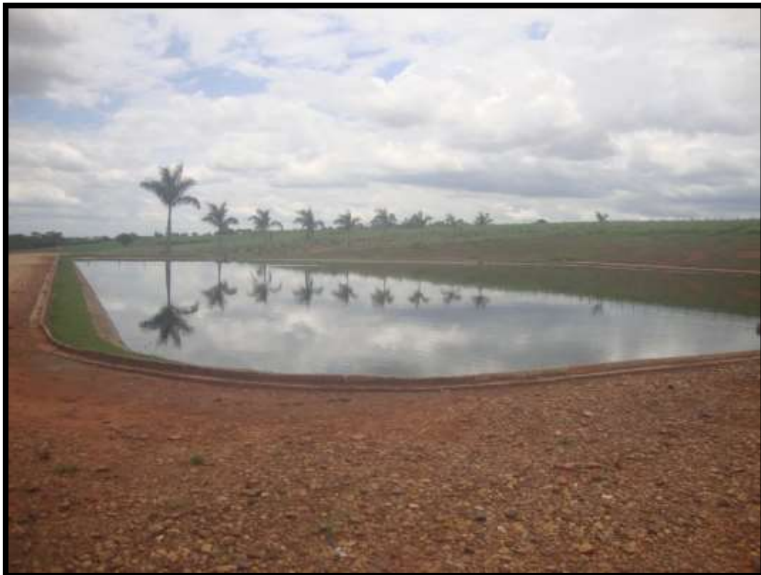
Figura 16 - Lagoa de tratamento 01
