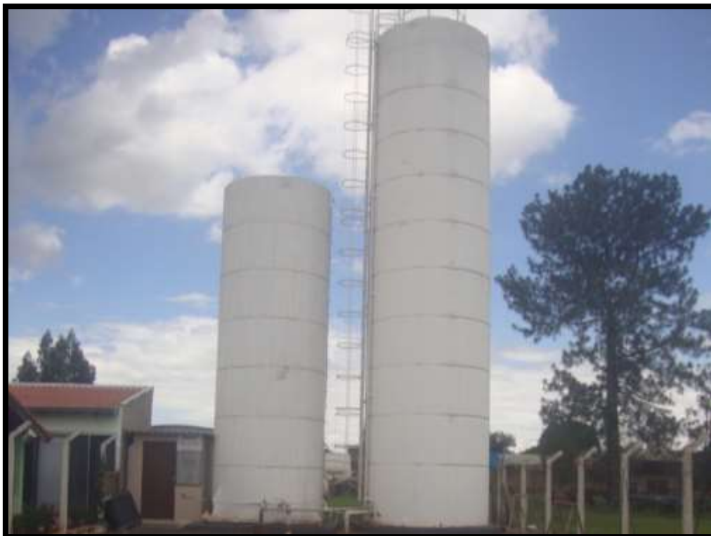
Figura 10 - Reservatórios do sistema 3
