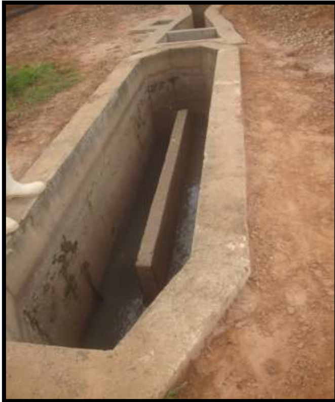
Figura 15 - Caixa de areia
