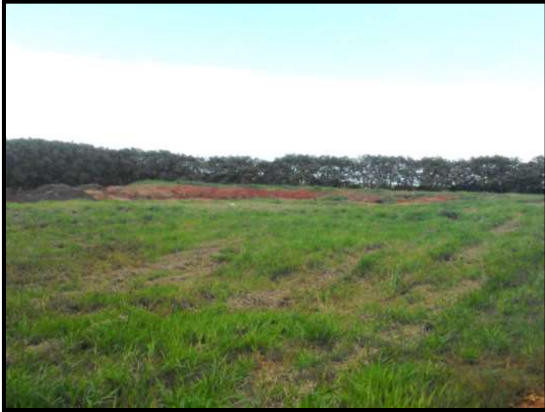
Figura 20 - Área do aterro em valas
