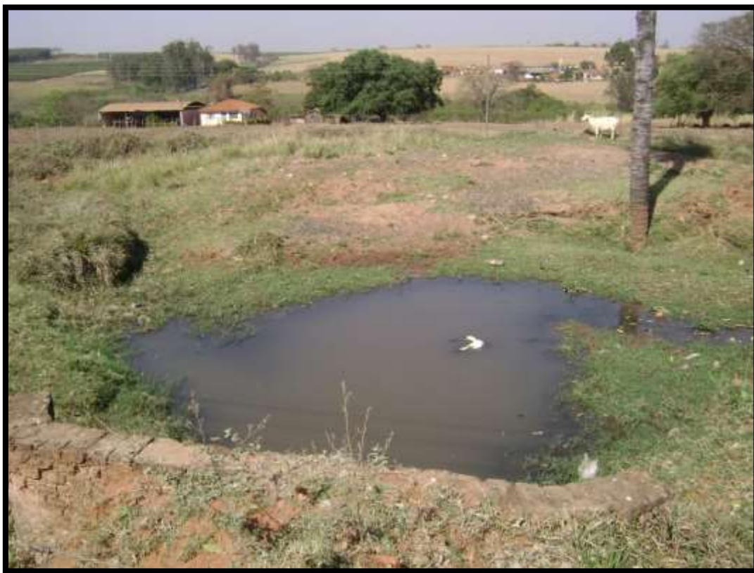
Figura 34 - Vista do lançamento das águas, após Avenida Consolação
